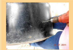
ใช้สว่านขนาด 3/8 นิ้ว เจาะรู
