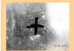
กำหนดจุดเจาะรูควบคุม อากาศ
