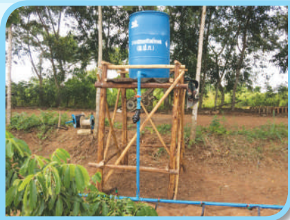
รูปที่ 15 ขาดังแบบใช้ไม้
