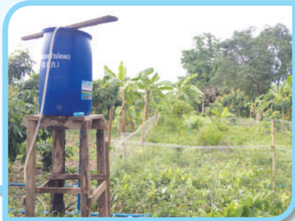
รูปที่ 15 ขาดังแบบใช้ไม้
