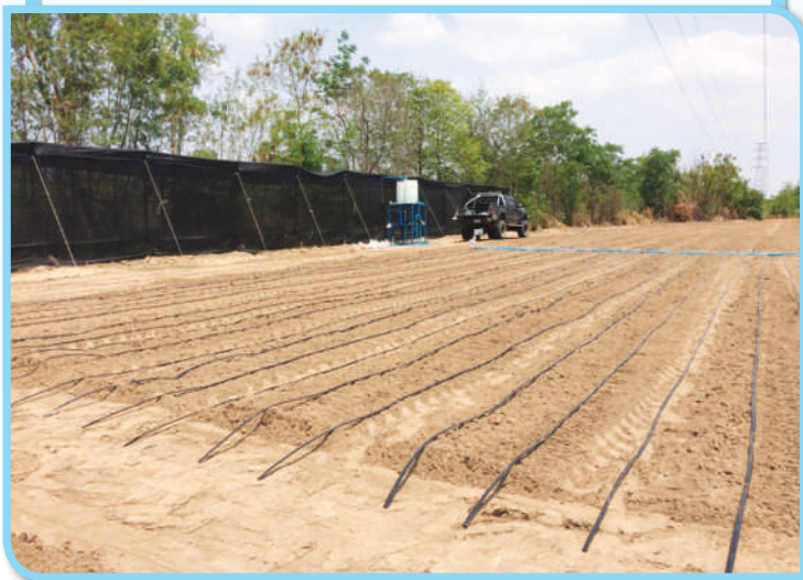
รูปที่ 38 ติดตั้งระบบสวนครัวน้ำหยด พื้นที่ปลูก 10 x 20 เมตร
