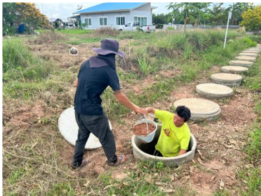
ค) ขุดลอกตะกอนที่สะสมภายในบ่อวง
