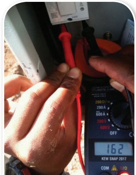
ภาพที่ 5 แรงดันไฟฟ้าที่วัดได้ขณะใช้งานปั้มน้ำขนาด 2 แรงม้า พบว่าแรงดันไฟฟ้าตกเหลือ 162 โวลต์
