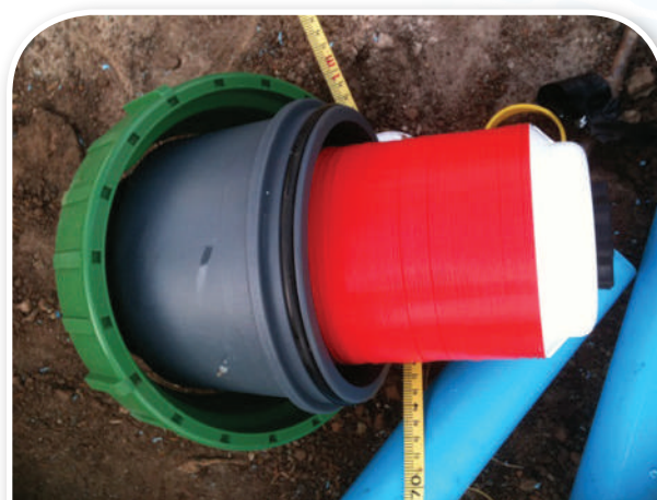
ภาพที่ 43 การติดตั้งกรองเกสรแบบแผ่น และใส้กรองแบบแผ่นสีแดงความละเอียด 120 Mesh
