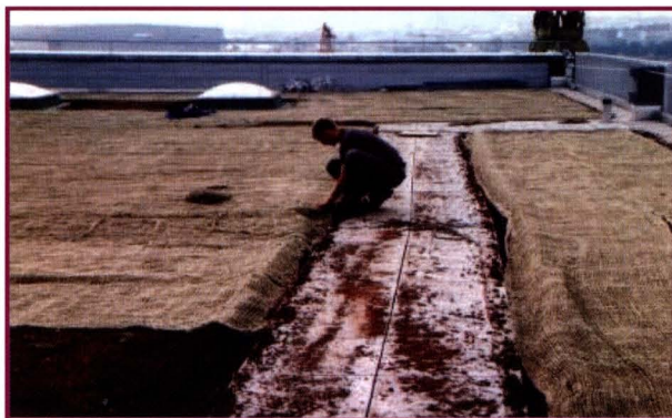
ภาพที่ 6.2 การใช้โยपाल์มคลุมวัสดุปลูกกันลมพัด
