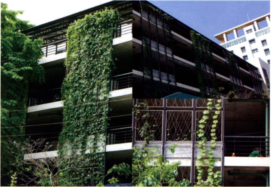
ภาพที่ 2.47 - 2.49 ผักเลื้อยบริเวณแผงกันแดด อาคารจอดรถรางมวงศ์วาน 1 และ 2
